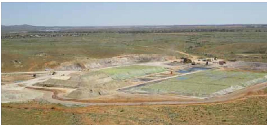
Pilas de lixiviación e instalaciones de proceso de Leigh Creek Copper
