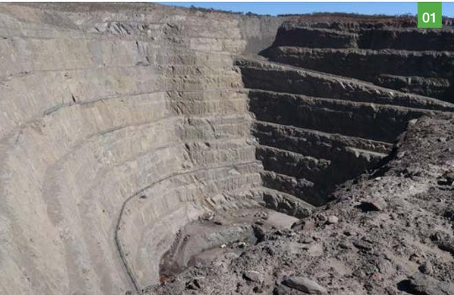
Kanmantoo Copper Mine se encuentra en Adelaide Hills, en el sur de Australia. En diciembre de 2018, alrededor de 6000 t de roca se deslizaron desde una altura de 24 m sobre una estructura de roca, luego de una falla en una serie de uniones J4 estrechamente espaciadas que bajaron abruptamente del muro oeste del rajo.
