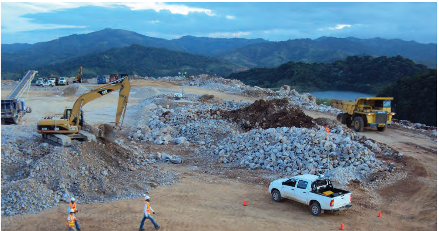
Escaneo móvil mejora la velocidad y seguridad durante una ocupada fase de construcción en la mina Pueblo Viejo
