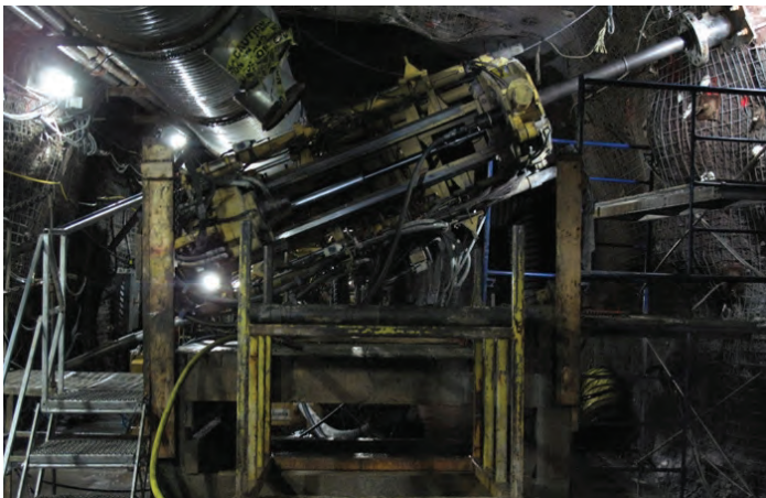
Se utiliza un taladro Cubex interno al agujero para perforar los agujeros de congelación a 520L
